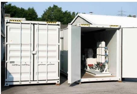
Hydrauliksystem eingebaut in 20'-Container für Außenaufstellung und Betrieb bei -50°C. Ex-Ausführung für Kanada (CSA-Zulassung).
